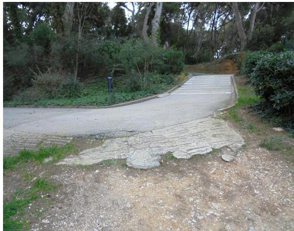
Un réel besoin dans ce secteur. La corrosion du béton vieilli dans cette pente, le dénivelé, les aspérités avaient rendu difficile ce passage.
